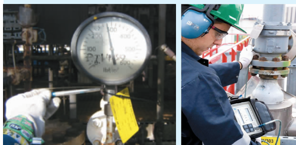
对发现的检测泄漏点进行挂牌整改
